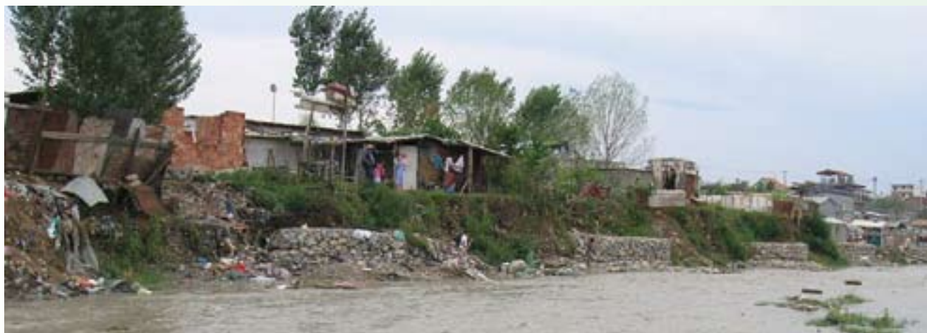
Gabionet e ndertuara nga projekti buze lumit per parandalimin e permbytjeve te shtepive
